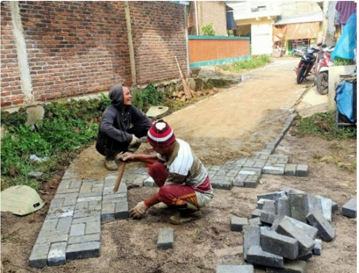
Proses Pekerjaan Pemasangan Paving Blok Jalan Lingkungan Kampung Lancar Desa Sukamanah dari Anggaran Dana Desa Tahap III Tahun 2021, Selasa (30/11/2021)
